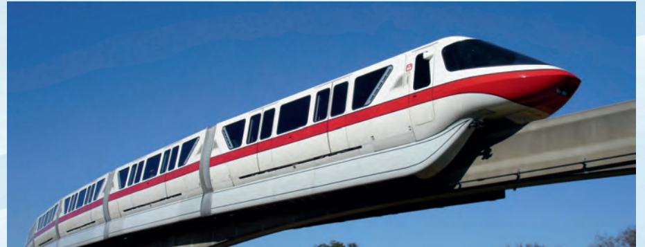
CADDE HAVARAY İLE DEĞERİNE DEĞER KATAKAK
