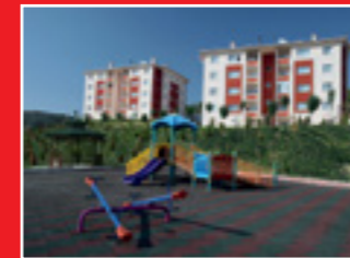
Kütahya Simav Afet Konutları
