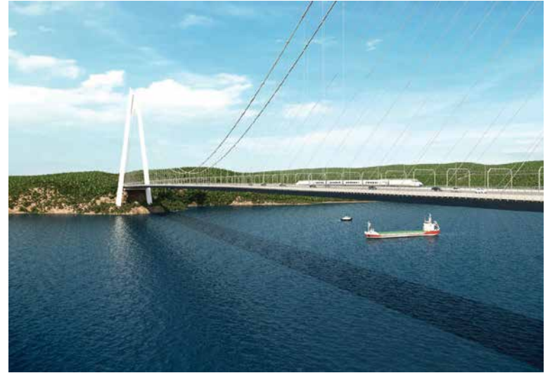
3. KÖPRÜ ÜZERİNDEN 8 ŞERİTLİ KARAYOLU VE 2 ŞERİTLİ TREN YOLU AYNI SEVİYEDE GEÇECEK. RAYLI SİSTEM MARMARAY VE İSTANBUL METROSU İLE ENTEGRE EDİLECEK.
